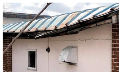
屋根の破損:言わずもがな。折れた部分から雨水が室内に入り込むほか、漏電につながるおそれがあります。
