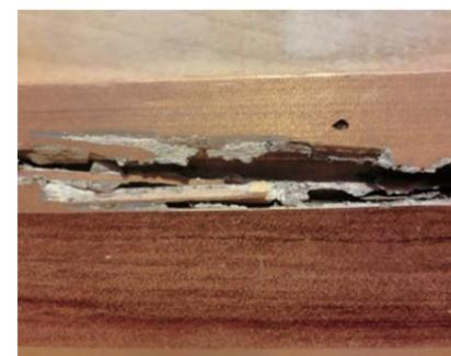
木部の蟻害:木造建物の場合、柱や巾木に虫食いの跡が見えたら要注意。付近の構造材も被害に合っている場合は、耐震性能が落ちます。急ぎの確認が必要です。
