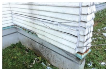
外壁の凍害:雪国に多い外壁サイディング材の劣化事象。放っておくと急激に劣化度が加速してしまいます。
