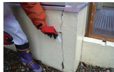
基礎クラック:ひびから水が入ると、内部の鉄筋が腐食。基礎強度が担保できないだけでなく、補修費も莫大に。早めに補修したい。
